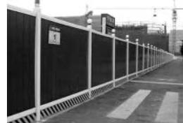
1、市区主要路段的工地应设置高度不小于2.5m的封闭围挡
