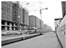
10、施工现场的主要道路及材料加工区地面应进行硬化处理
