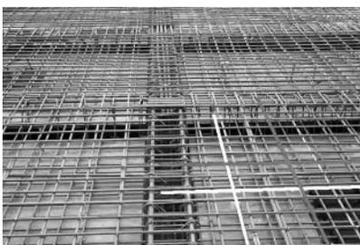
(1) 以板的开间、进深跨度区分：如果是单项板，那么平行于短跨方向的钢筋是受力筋，平行于长跨方向的钢筋是架立筋。如果是双向板，那么长跨、短跨方向的钢筋全部是受力筋。
