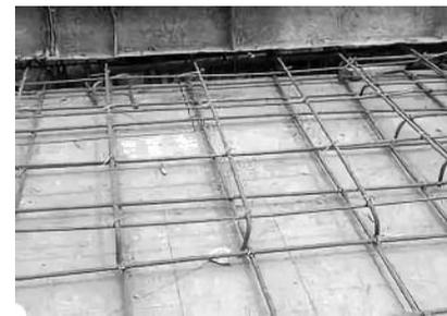
负筋就是负弯矩钢筋，弯矩的定义是下部受拉为正，而梁板位置的上层钢筋在支座位置根据受力一般为上部受拉，也就是承受负弯矩，所以叫负弯矩钢筋。（支座有负筋，是相对而言的，一般应该是指梁的支座部位用以抵消负弯矩的钢
