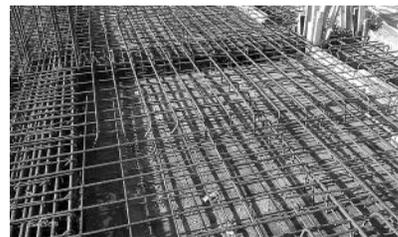
分布筋出现在板中，布置在受力钢筋的上部，与受力钢筋垂直。作用是固定受力钢筋的位置并将板上的荷载分散到受力钢筋上，同时也能防止因混凝土的收缩和温度变化等原因，在垂直于受
