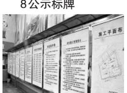
39、大门口处应设置公示标牌，主要内容应包括：工程概况牌、消防保卫牌、安全生产牌、文明施工牌、管理人员名单及监督电话牌、施工现场总平面图
